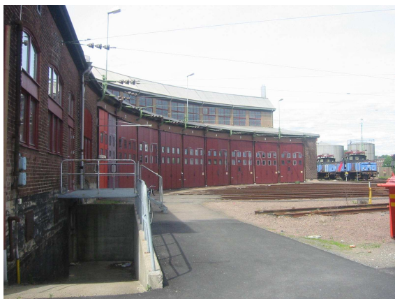
Det norra lokstallet.
