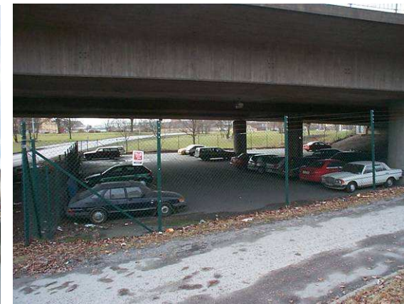
Viadukten vid Gamlestads Torg österifrån.
