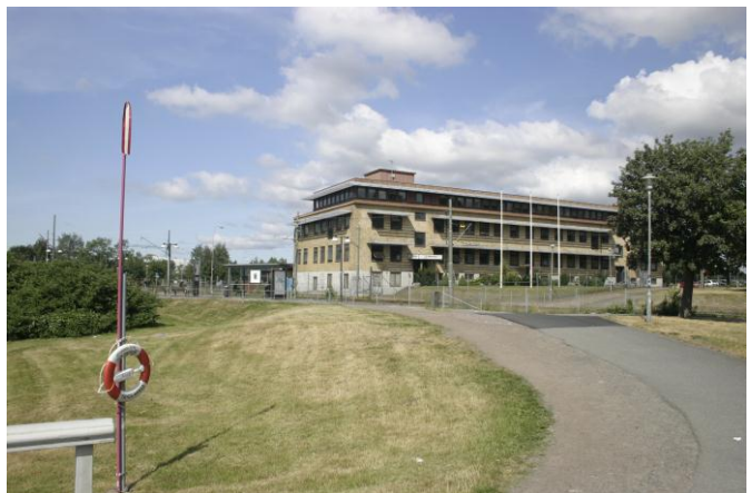
Tegelbyggnaden vid Johan Gertssons gata har rivits.
