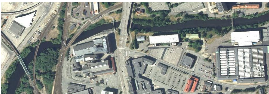
Ortofoto över Säveån från 2008. Viadukten för Gamlestadsvägen passerar över ån mitt i bild. Från viadukten och västerut är strandskyddet upphävt och sträckan utgörs av makadamlänter samt en knappt en meter hög stödmur med ca 60 m delvis överhängande grönska. Sträckan öster om viadukten omfattar en tät vegetationsbård på båda sidor om ån av stort naturvärde.
