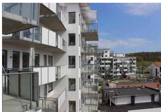
2016: Nya bostadshus vid Vänortsgatan Foto: Heléne Karlsson, Mölndal
