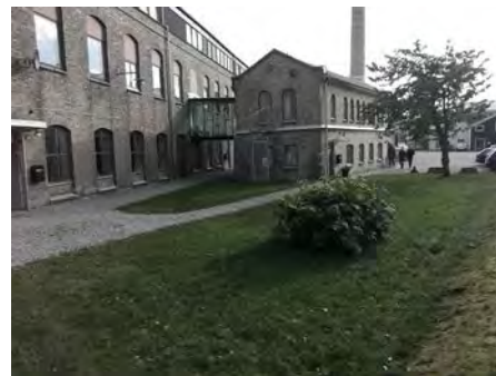
Almedals fabriker är en spännande miljö med renoverade gamla fabriksbyggnader.
