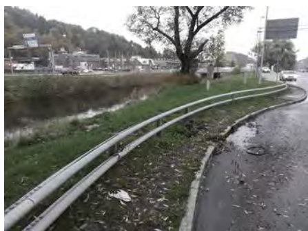
Utefter Ågatan mellan Lackarebäcksmotet och Gunnebogatan dominerar trafikmiljön. En skyddad gångpassage saknas idag men bör kunna ordnas närmare än.
