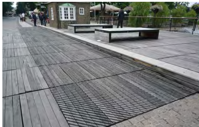
Gång- och cykelbro i trä. Körbanan för cykel kan räfflas för att minska halkrisken. Ett hårt träslag är viktigt, exempelvis hardwood som tål att sandas under vinterhalvåret.
