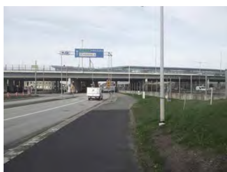
Vid Mölnåls centrum är Mölnålsån kulverterad men skulle i framtiden kunna synliggöras igen i en ny park nära centrum.
