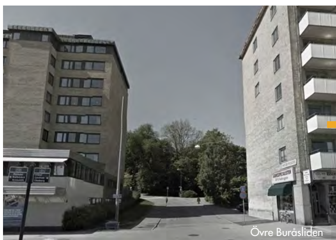
Gaturummet vid Övre Buråsliden kan upplevas grönt...
