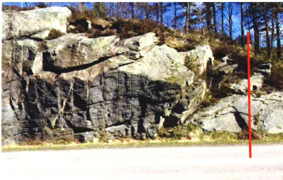
Bergskärning i norr utmed Gårdstensvägen, där plangränsen markerats.
