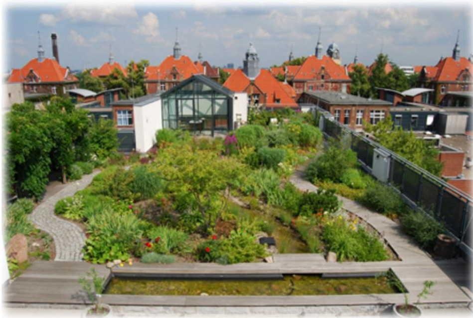
Figur 5 Trädgårdstak, kan utformas på olika sätt med olika fördröjningsmöjligheter (Foto: Svenska Naturtak)
