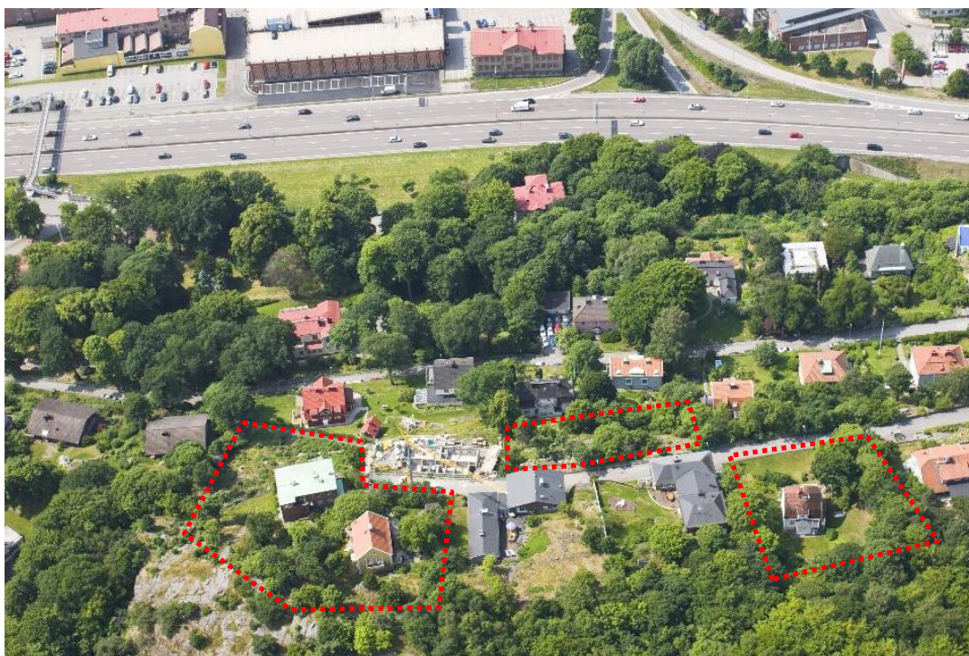
Flygbild tagen från öster. Ungefärligt planområde redovisat med röstreckad linje. Bebyggelsen är placerad i en kraftig sluttning ned mot Kungsbackaleden/E20/E6 i väster.
