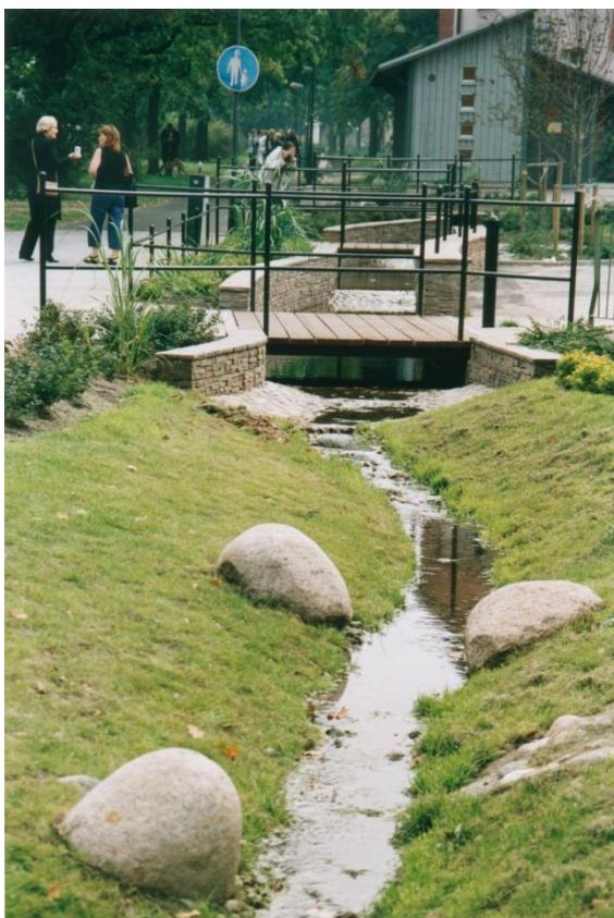
Figur 2 Grässlänter för översilning och dike för fördröjningskapacitet (Augustenborg, Malmö)
