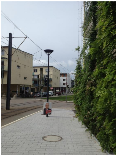
Figur 3 Grönska i begränsade utrymmen (Vauban, Freiburg)
