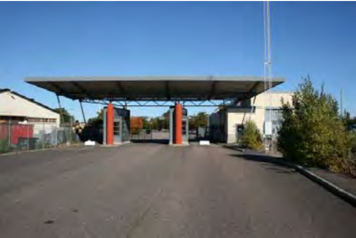
Byggnad 4, entrébyggnad till arenan.
