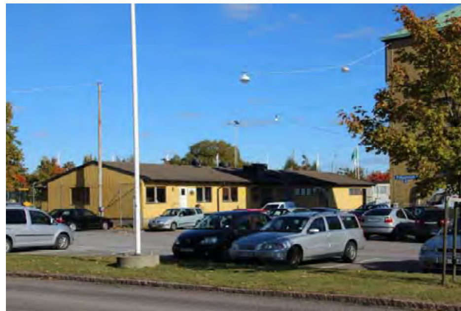
Byggnad 8, mindre kontorsbyggnad.
