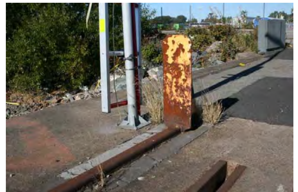
6. Kranstopp ● I inre änden av kranbanan på Norra frihamnspiren finns en enskild kranstopp, som använts för att bromsa kranarna. Den ger en direkt påminnelse om områdets historia och är av stor betydelse för förståelsen och läsbarheten i miljön som helhet.
