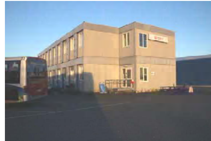
Byggnad 14, Veolias baracker.
