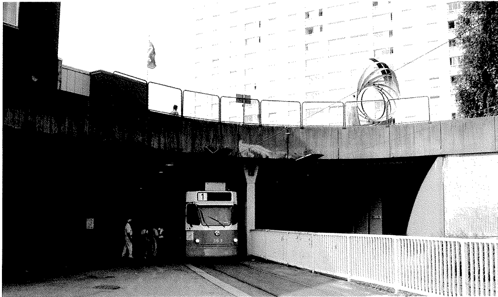
Spårvagnshållplatsens norra öppning
