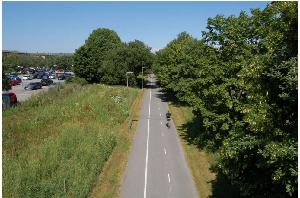
Gång- och cykelväg utmed västra sidan av Dag Hammarskjöldsleden vid Järnbrott, vy mot norr
