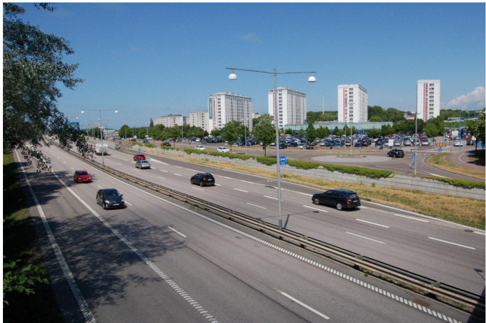
Västerleden med parallella lokalgator utgör en kraftig barriär mellan Frölunda och Tynnered
