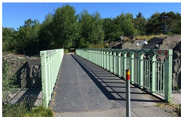
FIGUR 4.2 Gångbro utgör koppling mellan områdena norr och söder om Söderleden
