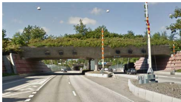
FIGUR 5.1 Ekodukt vid Södra Länken, Stockholm. Bild från Google Maps.
