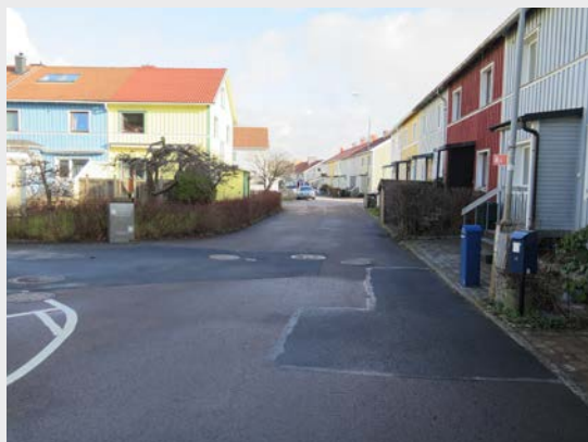
Kv Stormhaken, Grundplattan
