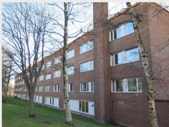
Kv Panelen: Toftåsens sjukhem
