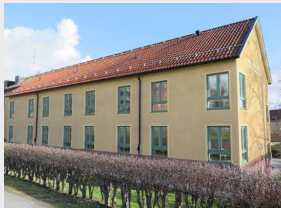
Kv Cementen: huvudbyggnad
