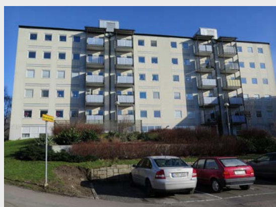
Kv Bjälken: Experimenthuset
