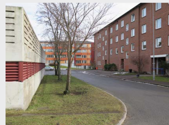
Kv Lamelldörren, Ytterdörren
