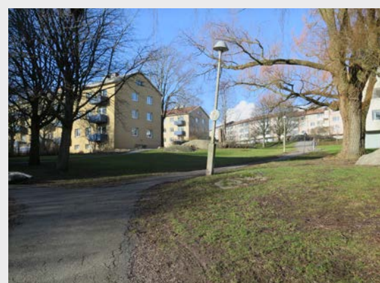
Kv Badkaret, Bottenplattan, Betongen m.fl.
