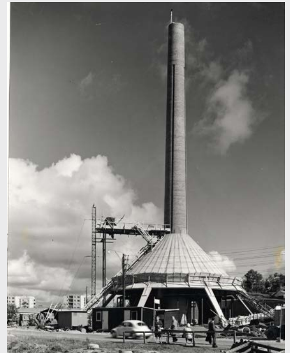
Panncentralen Tratten under uppbyggnad. Sjöstedt 1962
