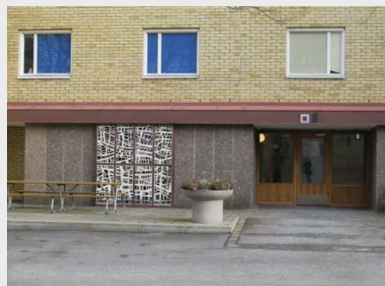
Kv Panelradiator, Garderoben, Skjutfönstret
