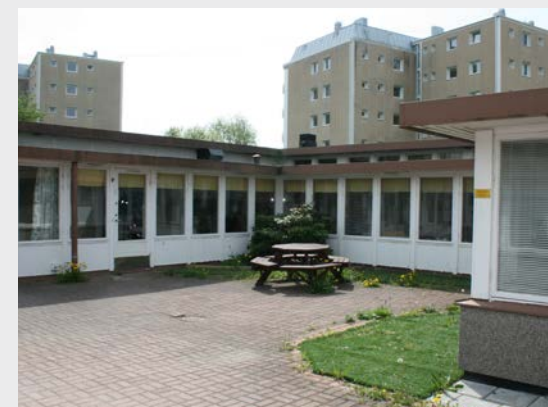
Kv Betongplattan, daghem, förskola
