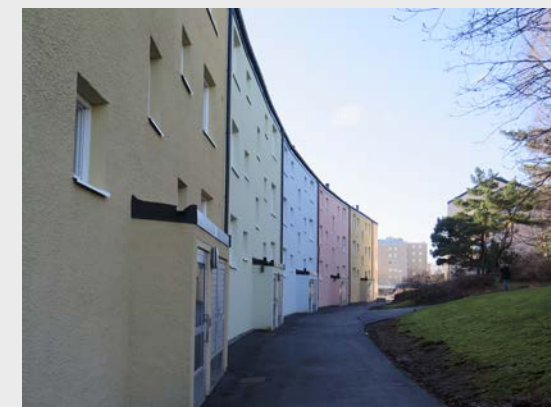
Kv Bjälken, Dörrlisten, Balkongen
