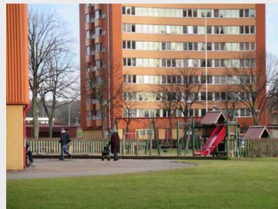
Kv Betongpålen: "Lösiggommarna"
