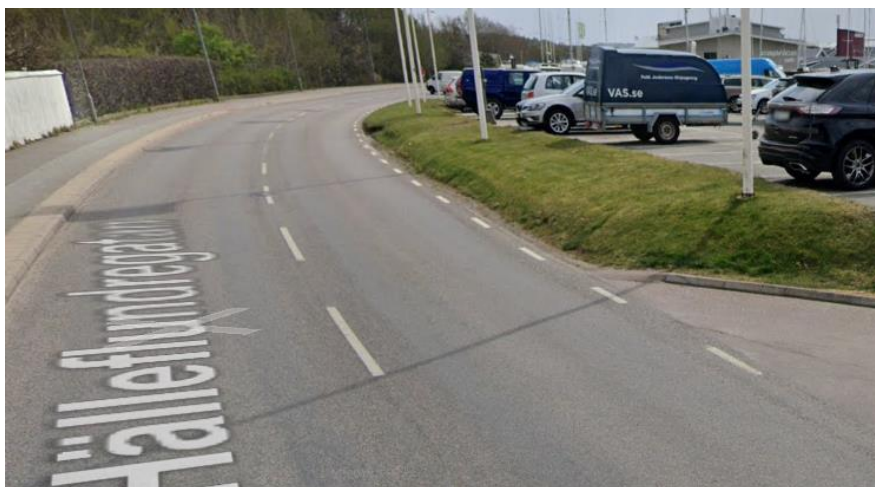
Figur 7. Dagvattenbrunnar saknas, dagvatten rinner in i gräsremsa (bild från Google maps).
