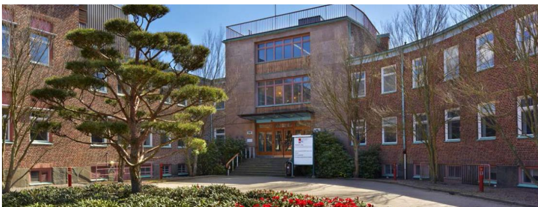
Eriksbergskontoret sett från norr vid huvudentrén.
