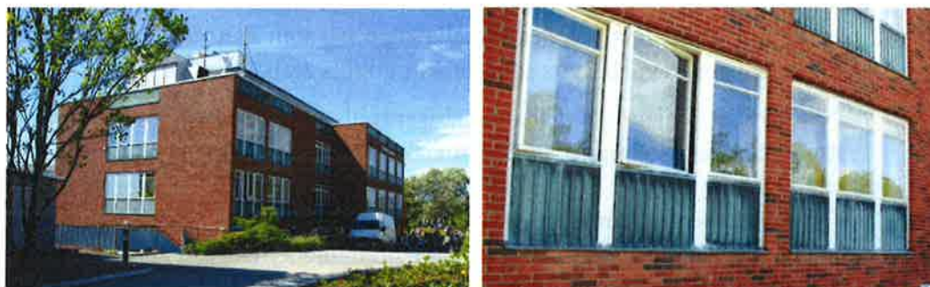
Eriksbergsgården (Donnergymnasiet) respektive detalj - fönsterpartier med kopparelement samt vertikalt glidhängda fönster.
