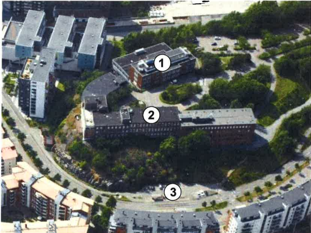
Befintlig bebyggelse inom planområdet. (1) Eriksbergsgården (Donnergymnasiet) och (2) Eriksbergskontoret. Vid Östra Eriksbergsgatan (3) syns även platsen som idag är planlagd för garage i tre våningar.
