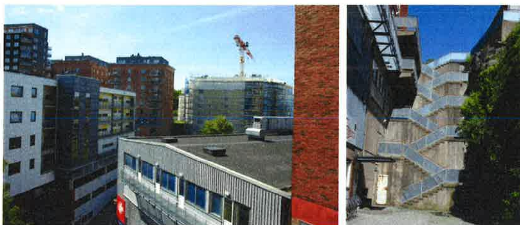
Aktivitetshallens gråa plåtfasad samt angöring från Bratteråsbacken upp till Celsiusgatan.
