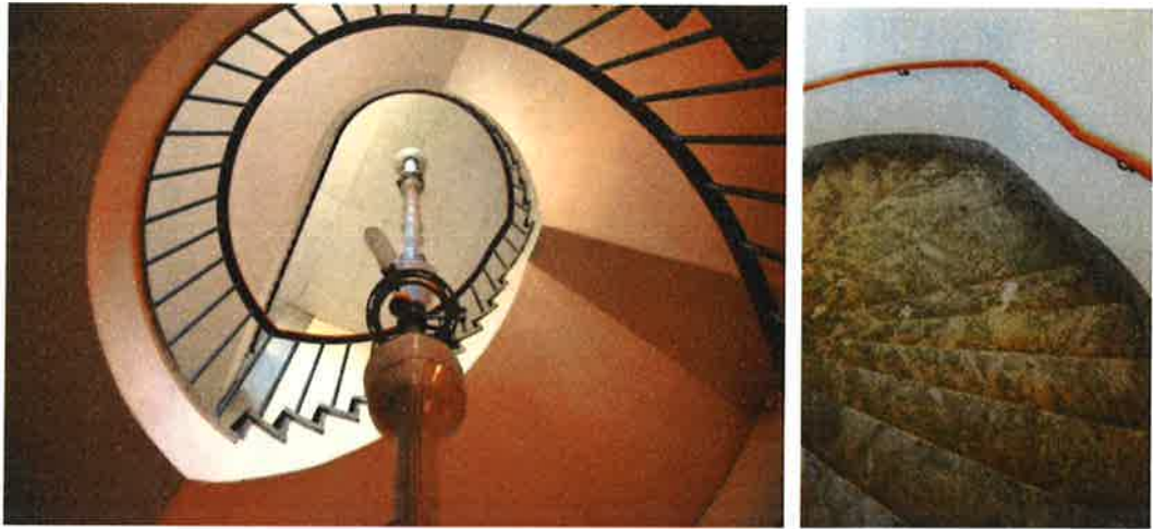
Trappans ljusföring med centralt placerad armatur, samt marmorklädda steg.
