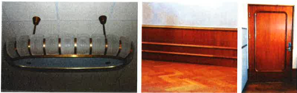
Nedpendlade armaturer, tilltagna golvlister platslagd parkett samt exempel på kontorsdörr.
