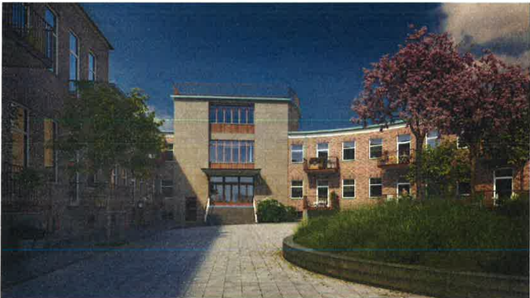
Möjlig utformning av entrén till Eriksbergskontoret, här redovisad med ny öppning i fasaden till vänster om befintlig entrétrappa (för att komplettera med en tillgänglig entré med hiss från gatunivå) samt balkonger. Illustration: Radar
