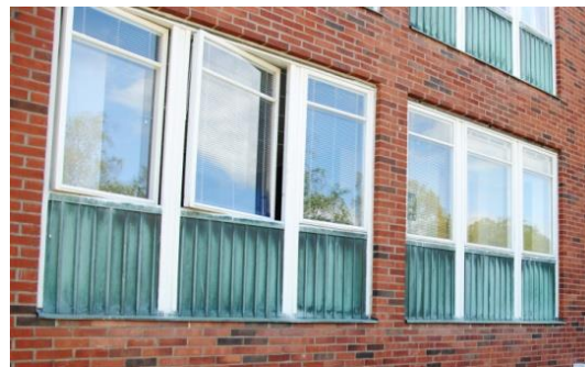
Eriksbergsgården (Donnergymnasiet) respektive detalj - fönsterpartier med kopparelement samt vertikalt glidhängda fönster.
