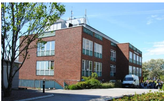
Eriksbergsgården (Donnergymnasiet) respektive detalj - fönsterpartier med kopparelement samt vertikalt glidhängda fönster.
