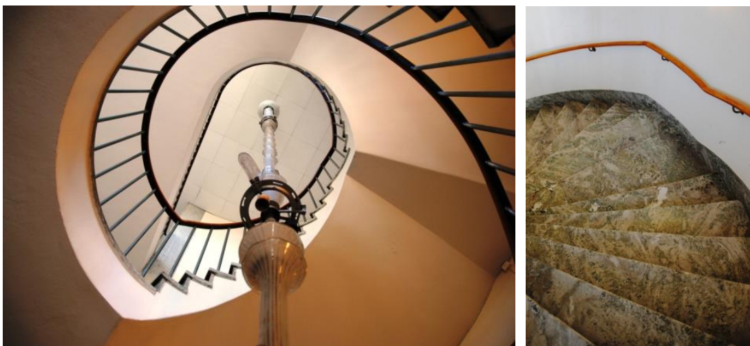
Trappans ljusförling med centralt placerad armatur, samt marmorklädda steg.
