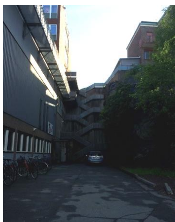
Trappan upp och mellan byggnaderna från sydväst
