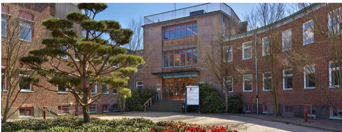
Eriksbergskontoret sett från norr vid huvudentrén.
