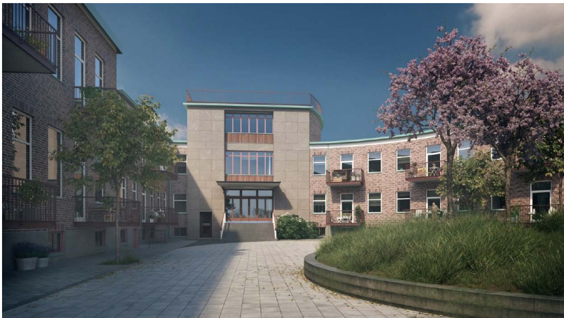
Möjlig utformning av entrén till Eriksbergskontoret, här redovisad med ny öppning i fasaden till vänster om befintlig entrétrappa (för att komplettera med en tillgänglig entré med hiss från gatunivå) samt balkonger. Illustration: Radar
