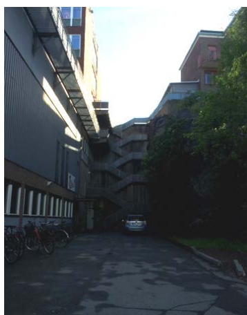
Trappan upp och mellan byggnaderna från sydväst
