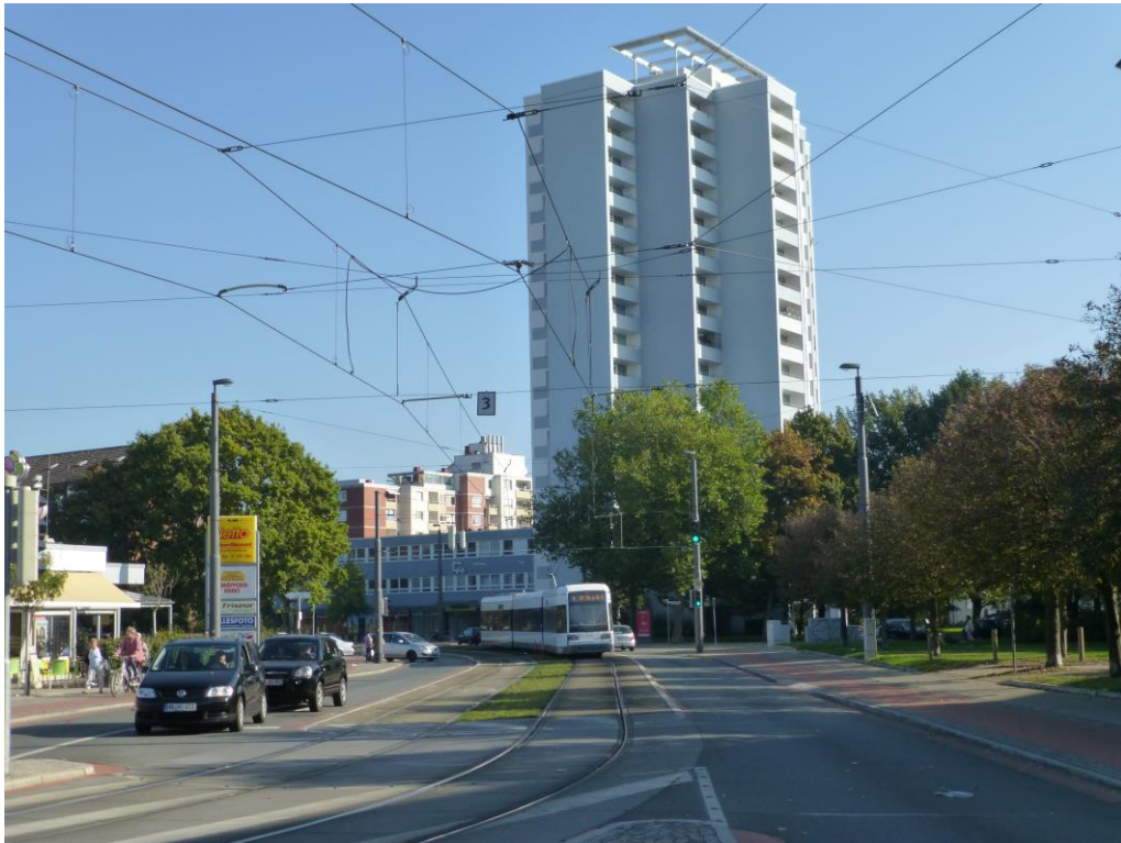
Figur 3 Bremen Schweizer-Eck, spårvägen öppnades 2012 som förlängning på stadsbana från 1970-talet. Vi ser tydligt hur spårvägen fått utrymme mitt i gatan, ett utrymme som tidigare disponerades av biltrafiken.
