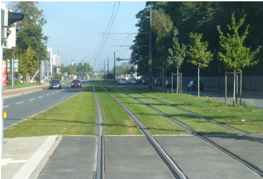
Figur 4 Utbyggnaden av linje 1 till Mahndorf öppnad 2016 är förlagd i centralt placerat grässpår.
