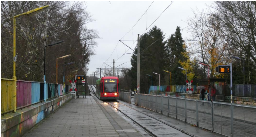
Figur 2 Bremen hållplats Robert-Koch Strasse byggd på 1970-talet där man på senare tid öppnat upp så det är tillåtet att korsa spåret i plan för ökad trygghet och tillgänglighet.
