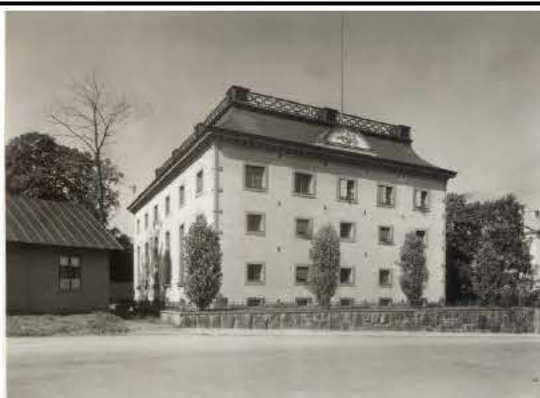
Elstationen 1935, intill en ekonomibyggnad tillhörande Gibraltar herrgård.
