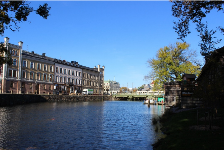
Foto från Trädgårdsföreningen mot norr. Tydlig rumslig uppdelning mellan trevånings bostadshus i tegel innanför vallgraven och Trädgårdsföreningens grönska och Vallgraven däremellan.
