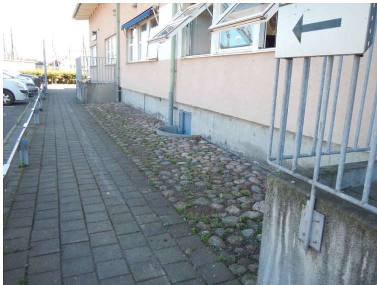
Figur 3 Stensättning på del av norra fasaden vid huvudbyggnaden
