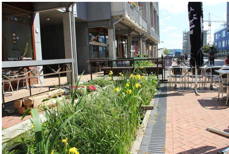
Figur 6 Biofilterdike med gallerförsedd ränna, i anslutning till uteservering (källa: VegTech)
