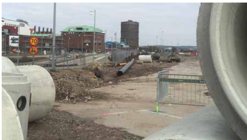
Ledningsarbeten vid Götaleden E45 påbörjades under 2015
