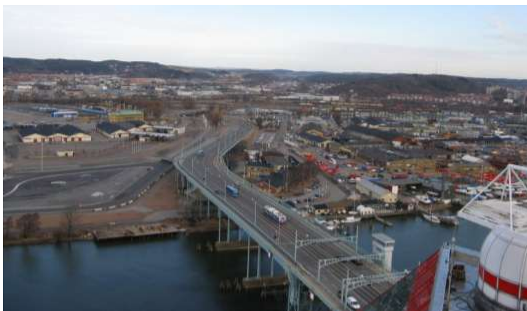
4.4 Vy mot Frihamnen, nuvarande bro och Ringön från "Läppstiftet"
