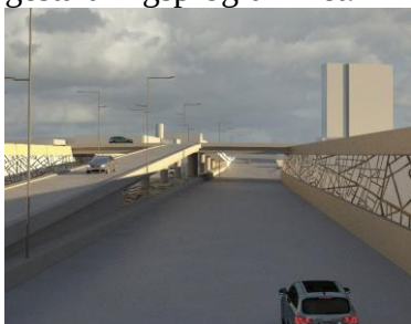
Figur 20 (t.v), Bilden är ett skiss över hur stödmurar skulle kunna utformas med mönster i betongen och detaljer av plåt (av Tyréns AB för Trafikverket).
