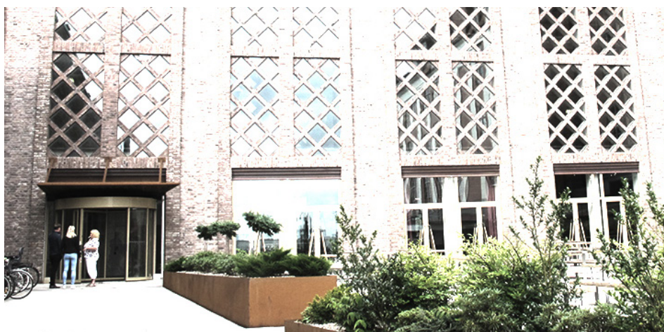
Figur 3. Omsorgsfullt upprustade byggnader och gårdsmiljöer, skyddade från vind och buller, skapar oaser i det annars otillgängliga industri- och verksamhetsområdet.
