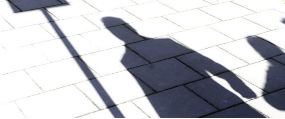
Figur 19. Gångstråk med betongplattor lagda i förband.
