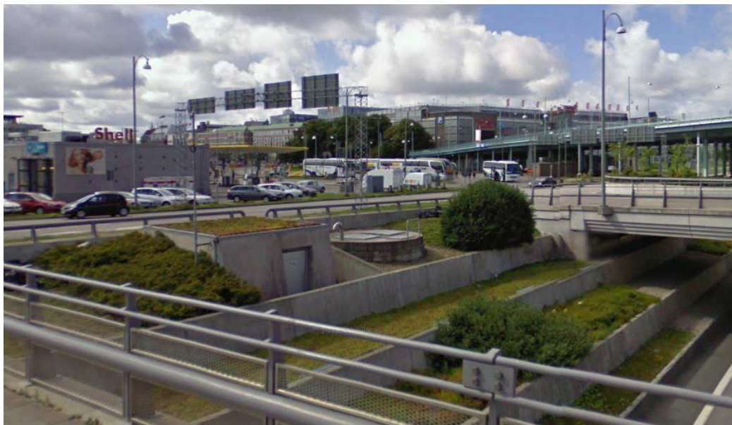
Figur 3. Befintlig dagvattenpumpstation vid Götatunnelns mynning.
