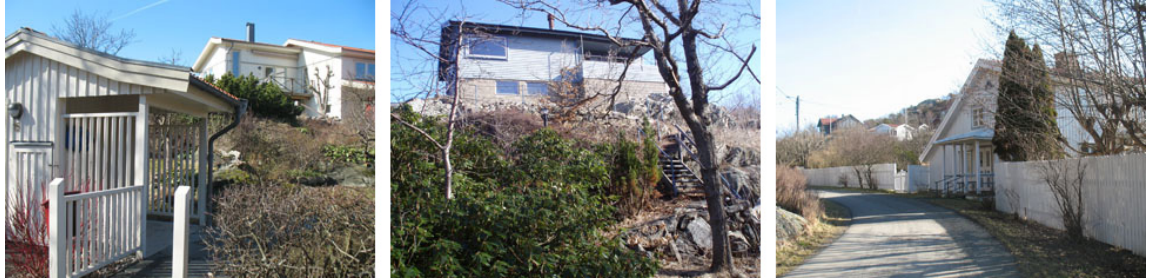
Figur 3 Befintlig bebyggelse på a) Brännö 5:47 b) Brännö 4:172 och c) Brännö 1:44 (Langegården).
