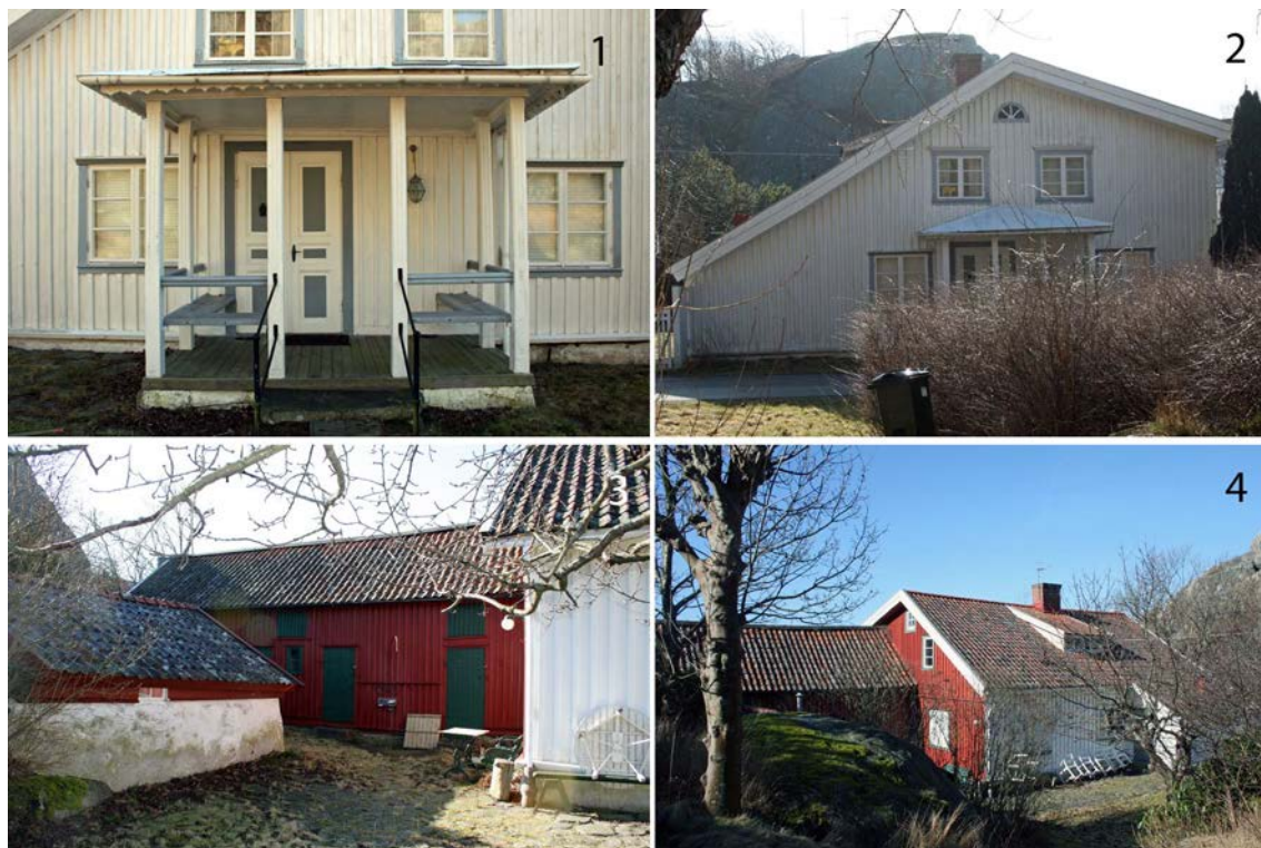
Figur 6 Foto 1 och 2 visar entrén och gaveln ut mot Husviksvägen. Foto 3 och 4 visar ekonomibyggnaden och sammanbyggnaden med bostadshuset samt källarvinden.
