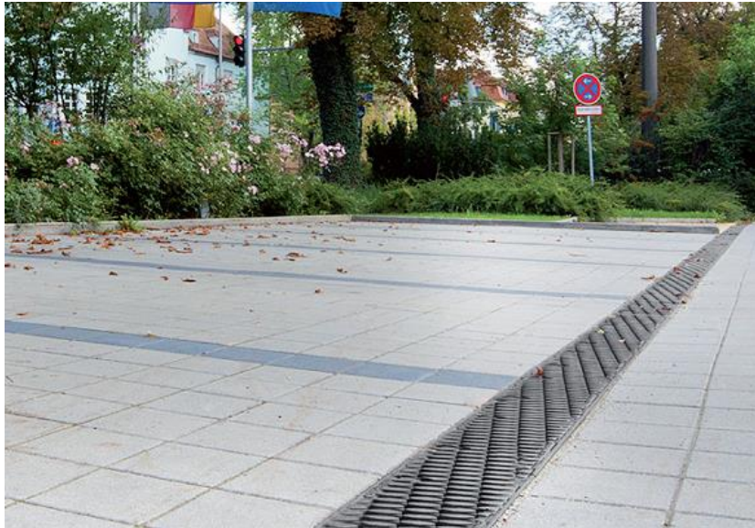
Figur 8. Ränna vid parkering med avledning mot grönyta
