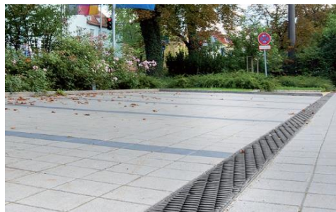
Figur 25. Ränna vid parkering med avledning mot grönyta.
