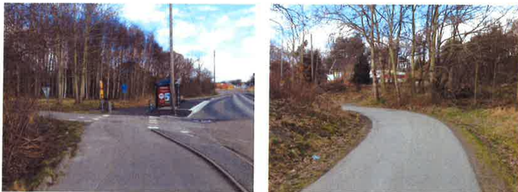
Korsningen Gamla Låssbyvägen/Kongahällvägen byggs om
