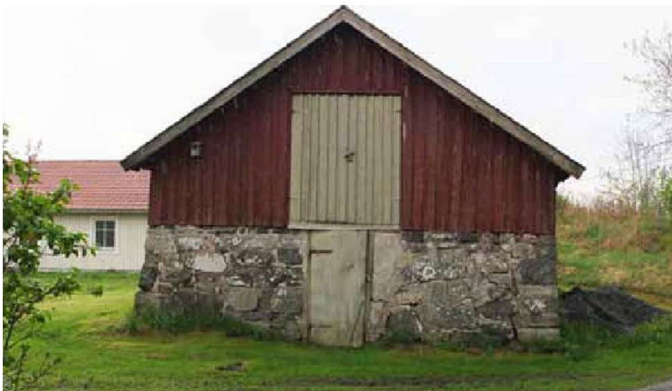
Fig. 2.3 Befintlig ekonomibyggnad i området med faluröd lockpanel och hög stensockel.
