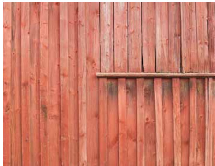
Figur 67. Faluröd lockpanel, det mest karaktäristiska för närområdets ekonomibyggnader.
