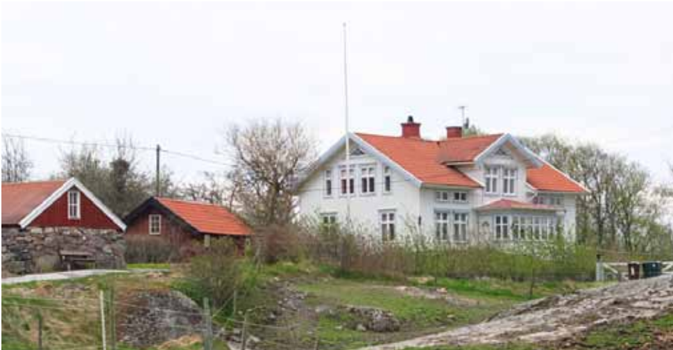
Figur 11. Bild från Kvislungeby, byggnaderna ligger kvar i en klunga.
