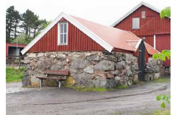
Figur 69. En källarvind med en kraftig naturstenssockel.
