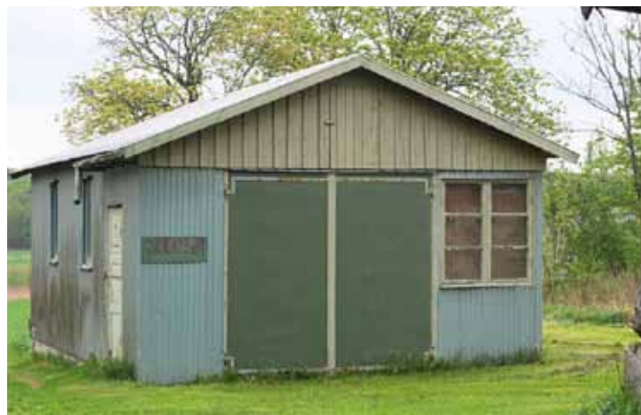
Figur 73. Plåt förekommer både som fasad- och takmaterial. Denna funktionalistiskt inspirerade färgsättning är annars ovanlig i området.
