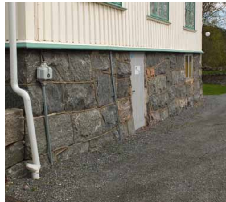
Figur 70. De flesta äldre byggnader är uppförda på en gedigen naturstenssockel.
