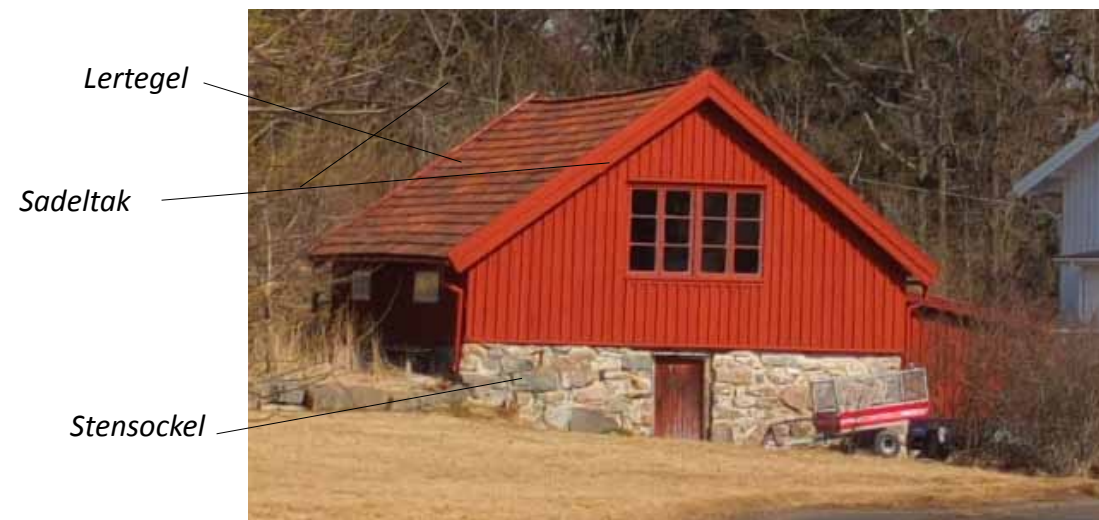
Figur 66. Källarvind är en vanlig byggnadstyp i området.
