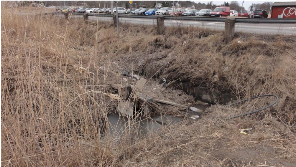
Figur 6. Trumma under Kongahällavägen som avleder bäcken till Osbäcken.
