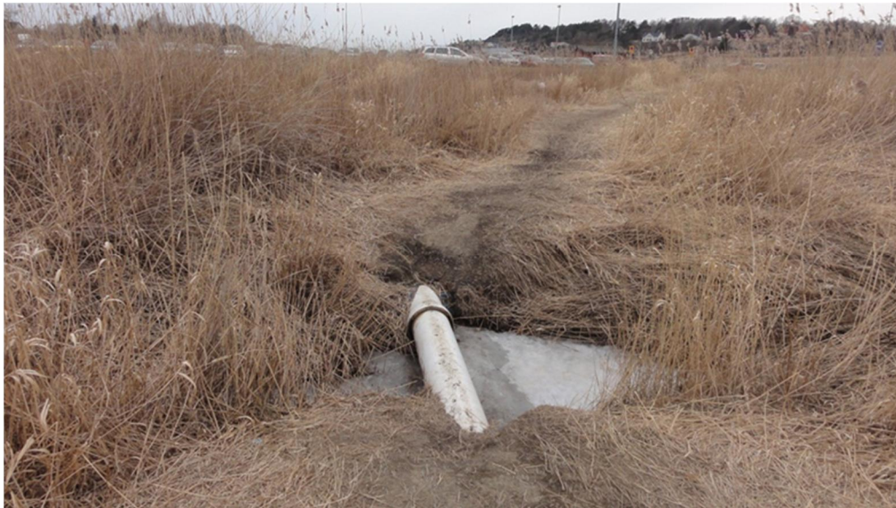
Figur 8. Befintlig spillvattenledning i skyddsror där den korsar bäcken genom planområdet.
