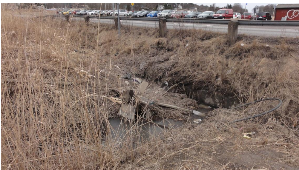
Figur 5. Trumma under Kongahällavägen som avleder bäcken till Osbäcken.
