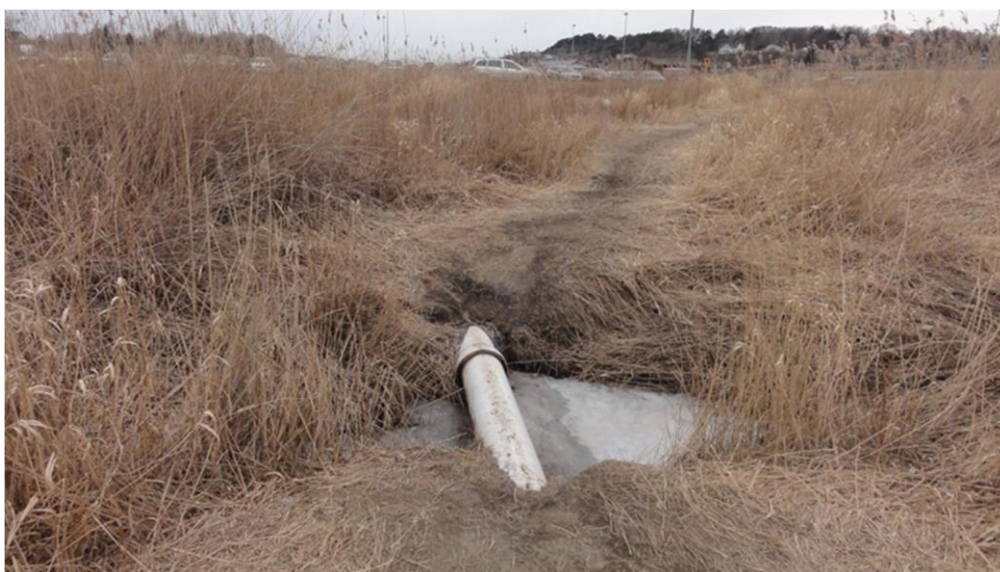
Figur 7. Befintlig spillvattenledning i skyddsrör där den korsar bäcken genom planområdet.
