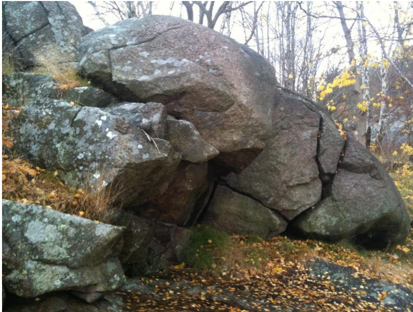
Figur 3: område 5 uppvisar instabila block som bör tas bort eller säkras, oavsett om sprängning kommer att utföras eller ej. Nedanför dessa block sluttar berget brant ner mot förskolans gård.
