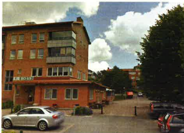
Bild på befintlig kombinerat kontors- och bostadshus med indragen andra våning söderut. Ytan söder om byggnadens gavel är körbar yta i förlaget.
