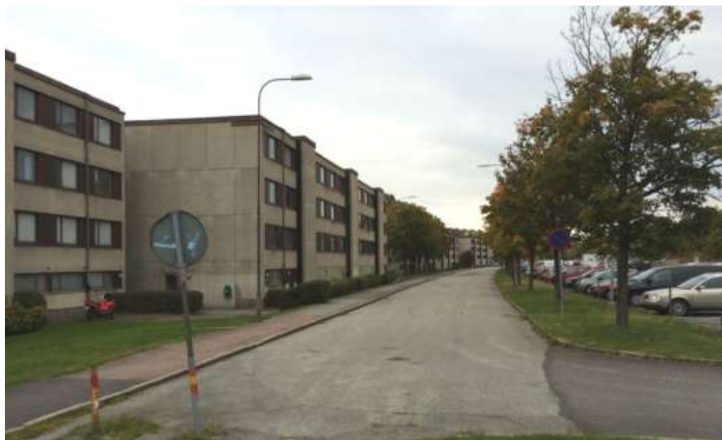
Bild på den befintliga lamellhusbebyggelsen utmed Långströmsgatan.
