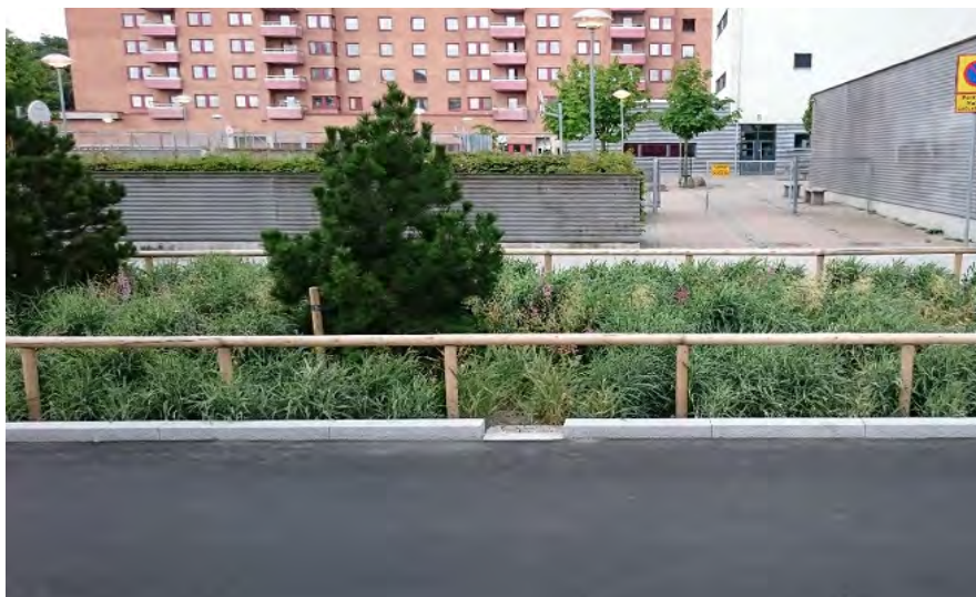
Figur 8: Nedsänkt växtbädd med inlopp genom nedsänkt kantsten. (sigmacivil.se)
