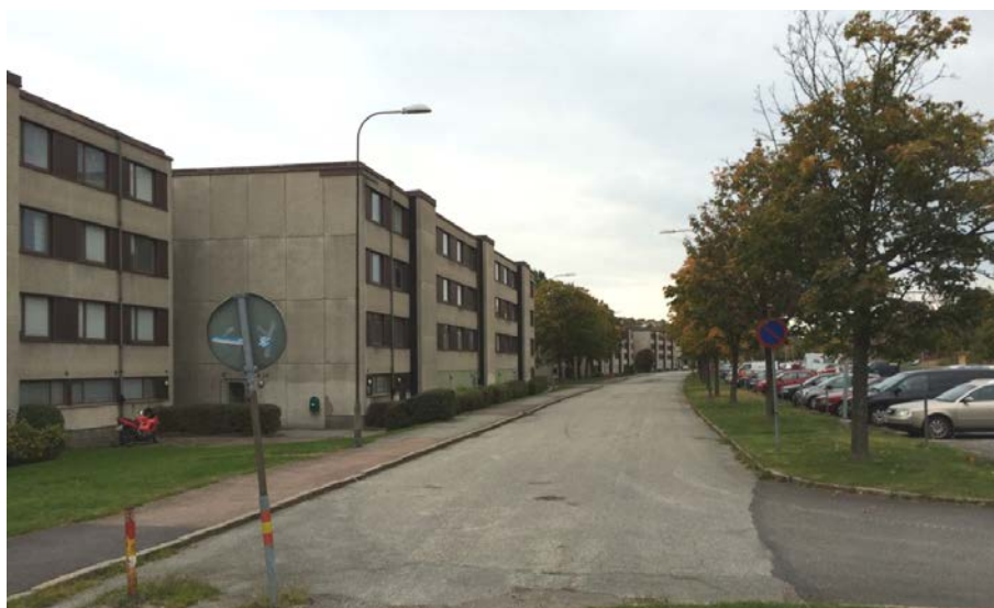
Bild på den befintliga lamellhusbebyggelsen utmed Långströmsgatan.
