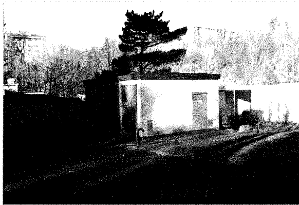
Olämpligt placerad transformator
