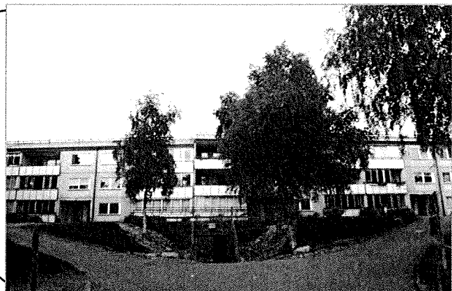
Gångtunneln under Kosmosgatan 25 sedd från krönet
