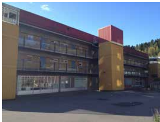
Bild: Loftgångshuset, Rymdtorget 7.
