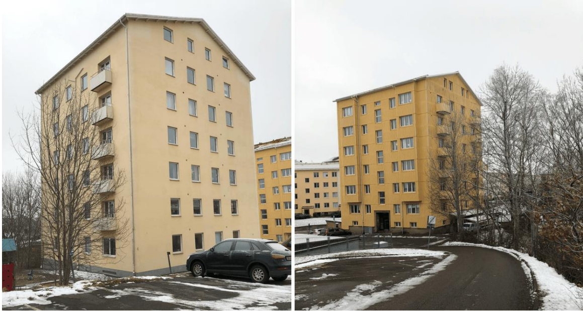
Figur 16: Exempel på funktionalistiska punkthus med inslag av nyrealism vid Wahlbergsgatan. Byggnaden på bilden till höger har tilläggsisolerats och förändrat fasadmaterial vilket gör att dess funktionalistiska karaktär delvis har förvanskats.
