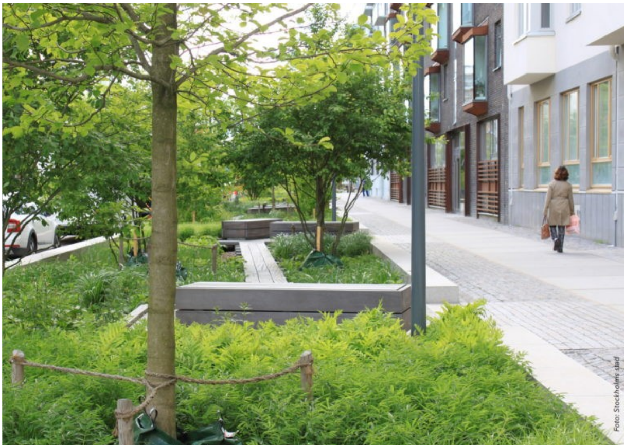
Figur 25 Inspirationsbild från Stockholms stad där biofilter anlagts på Jaktgatan i Norra Djurgårdsstaden som en del av den gröna korridoren (Stockholms stad, 2020).
