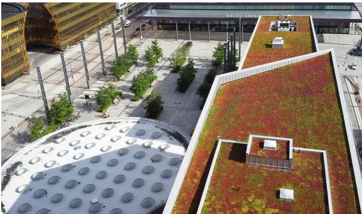
Figur 22 Exempelbild av ett sedumtak. Bild från Veg Tech (Veg Tech, 2020).
