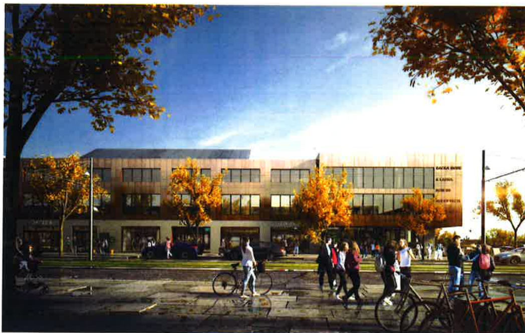
Den befintliga gallerian byggs om så att entréer kan vändas ut mot Backavägen. Dreem Arkitekter
