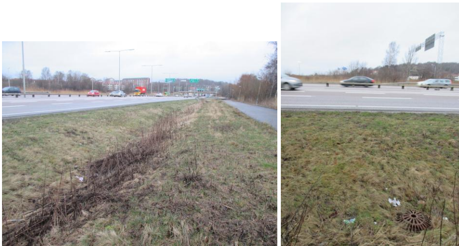
Bild 2. Söder om Lundbyleden. Befintligt dike och kupolbrunn.
