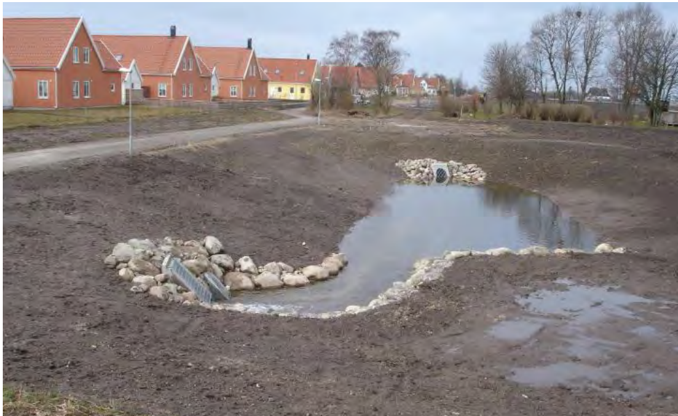
Bild 10. Födröjningsdamm. Källa: www.vasyd.se .
