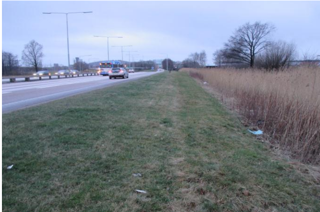
Bild 3. Norr om Lundbyleden. Befintligt dike intill vattensjukt område och flack väglänt.
