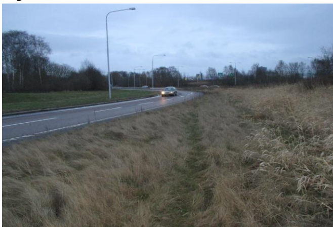
Bild 4. Avfarten Östra Magårdsvägen.
